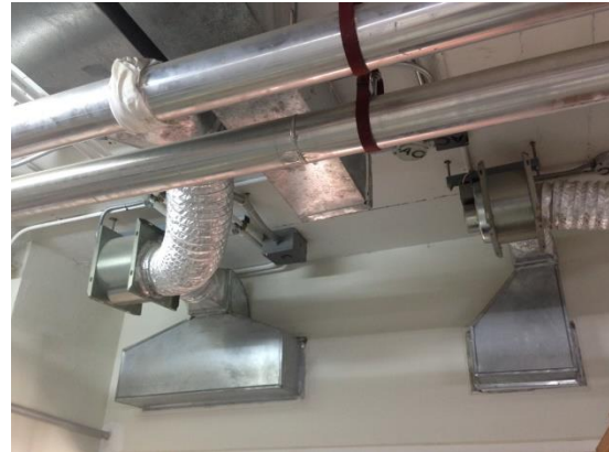
ภาพแสดง ระบบระบายอากาศ
